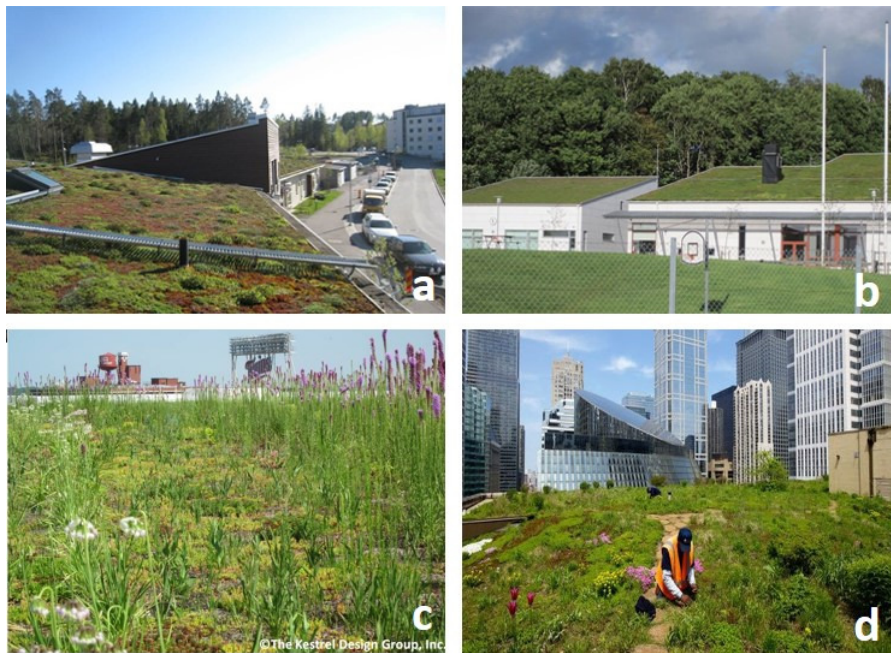
Figur 7. a)-b) Lutande, gröna bostadstak, Sverige (källa: Vegtech.se), c) extensivt sedumtak kompletterat med inhemska växter på Target Centre i Minneapolis, USA (källa: The Kestrel Design Group Inc.), d) stadshuset i Chicago, USA (källa: JoeInSouthernCA Flickr CC BY-ND 2.0).
