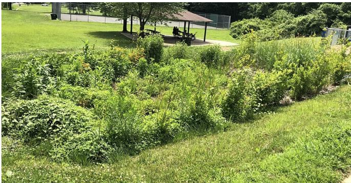
Figur 14. Exempel på en nedsänkt växtbädd för fördröjning av dagvatten för parkmark (för rening och eventuell flödesutjämning). 12
