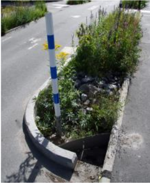
Figur 17. Exempel på hur ett avbrott i kantstenen kring en växtbädd kan användas för att skapa ett inlopp för dagvattnet. Bild av WRS hämtad från Stockholm Vatten och Avfall (SVOA).
