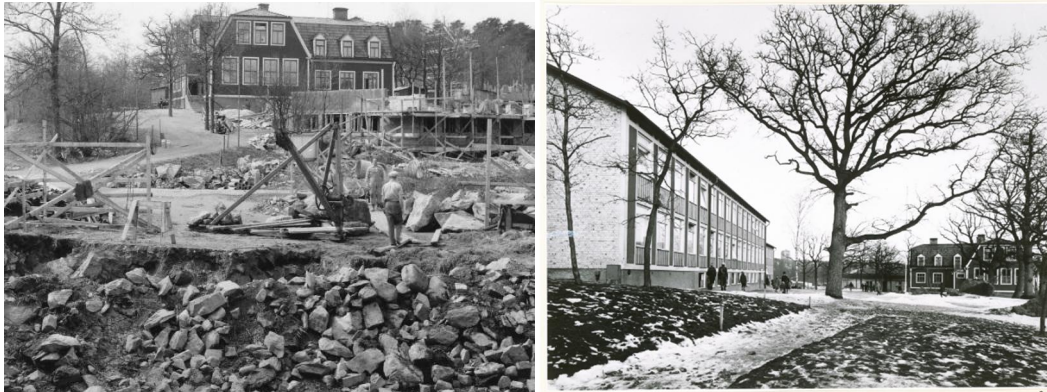
T.v. Skolgården och hus C under uppbyggnad med den gamla folkskolan i bakgrunden. (nacka.se) T.h. Skolgården när skolan stod klar, i slutet på 1950-talet. (nacka.se)
