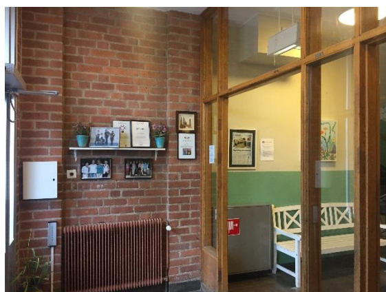
Bevarat glasat träparti vid huvudentrén till skolan i tidstypisk utformning och material. Ett värdebärande karaktärsdrag.
