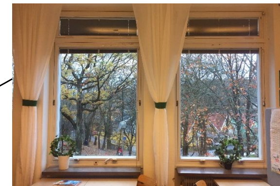
I princip alla fönster i byggnaden är ursprungliga. Med större fönster åt söder för klassrummen och mindre åt norr. I princip alla fönster har fönsterbänkar av kalksten. Värdebärande karaktärsdrag .
