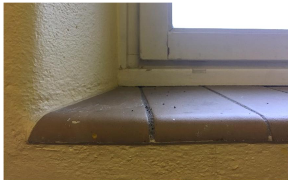
Fönsternisch med fönsterbänk av brun klinker med fasad kant samt rundade putsade hörn , karaktäristiskt för 1950-talets känsla för detaljer. Förstärkande karaktärsdrag .
