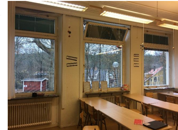
I princip alla fönster i byggnaden är ursprungliga. Med större fönster åt söder för klassrummen och mindre åt norr. I princip alla fönster har fönsterbänkar av kalksten. Värdebärande karaktärsdrag.
