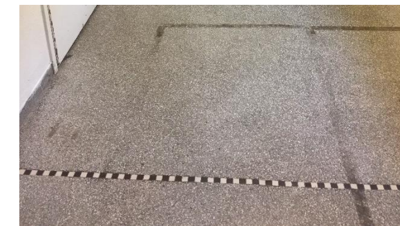
Ursprungligt golv med ränder av svart och vit mosaik utanför det nuvarande musikklassrummet. Ett värdebärande karaktärsdrag.
