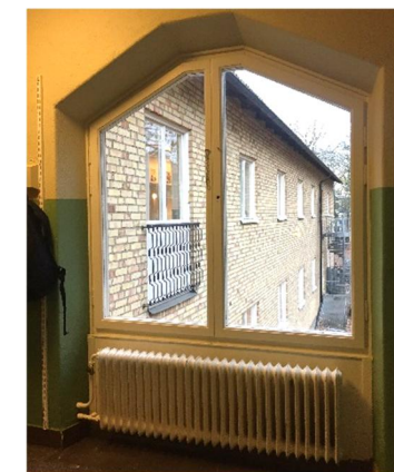
Ursprungligt fönster med tidstypisk utformning. Ett värdebärande karaktärsdrag. De ursprungliga sektionsradiatorerna är förstärkande karaktärsdrag.
