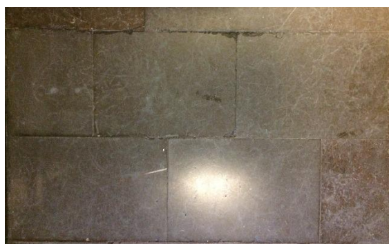
I trapphusen är det genomgående kalkstensgolv med synliga fossiler, ett tidstypiskt material i offentliga miljöer som skolor under 1950-talet. Ett värdebärande karaktärsdrag .
