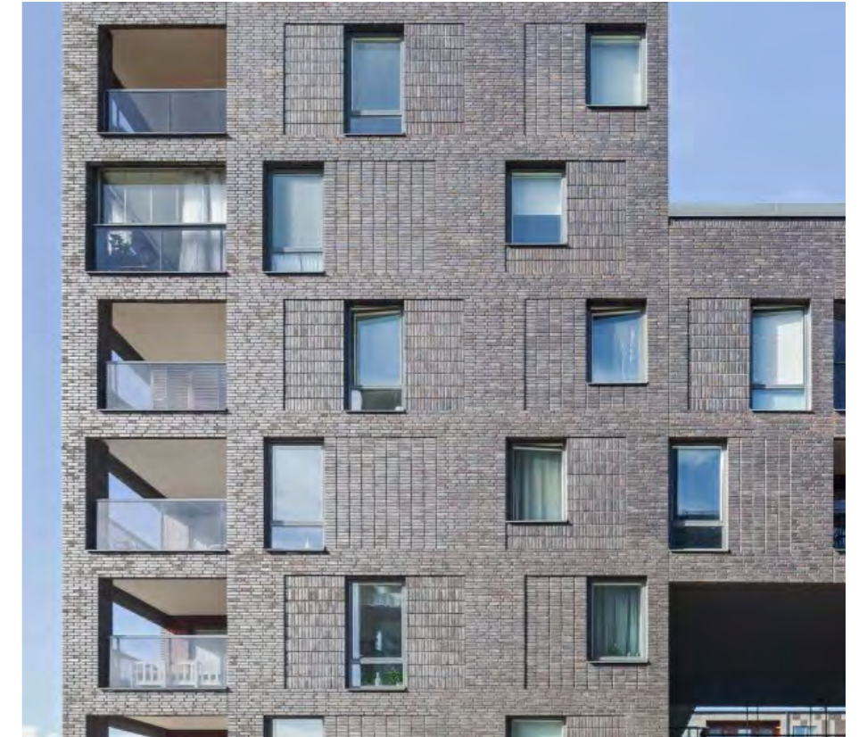
Balkonger infällda i fasad tex i hörnor och mot hårt trafikerade gator. (Kv. Maja Gräddnos, Kalmar)
