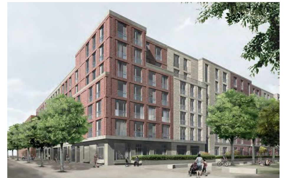
Artikulerad hörnbyggnad, sockelväning urskiljer sig från övriga våningar. Lokaler och bostadskomplement vätter mot gata. (Altona, Hamburg)
