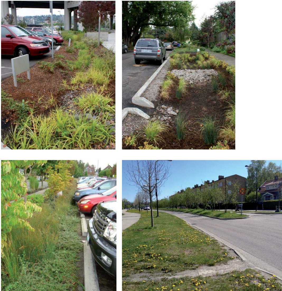
Figur 11. Exempel på utformning av svackdiken längs gata och parkeringsyta, med olika typer av kantsten och utan kantsten. Bilden nedan th är tagen på Sockenvägen i Stockholm, övriga är tagna i Portland, USA.
