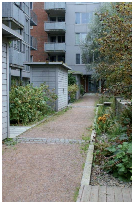
Figur 15. Exempel på permeabla beläggningar i Berlin, Stockholm och Oslo.
