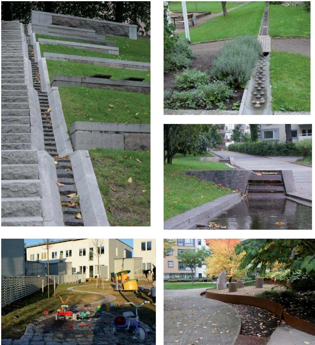
Figur 14. Exempel på ränndalar och yttlig avledning i Oslo, Stockholm och Malmö.
