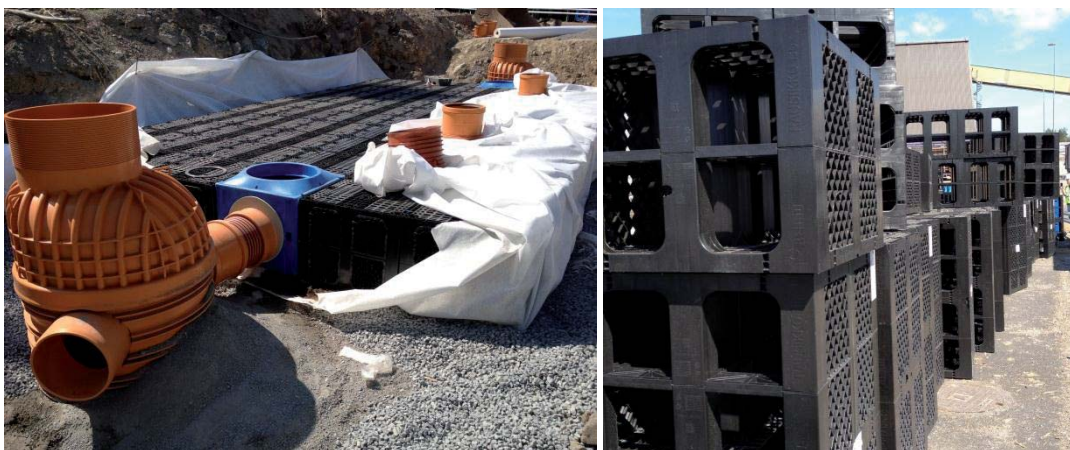
Figur 19. Exempel på dagvattenkassetter i Stockholm.
