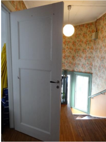
Ursprungliga dörrblad med två speglar. Den enkla dörrformen med två fyllningar anknyter på nationalromantiskt vis till ålderdomliga allmogedörrar som i sin tur hade hämtat dörrtypen från renässansens och barockens tvåfyllningsdörrar i högreståndsmiljöer. Trycke och nyckelskylt från byggnadstiden tidigt 1900-tal. Foto Johan Aspfors.
