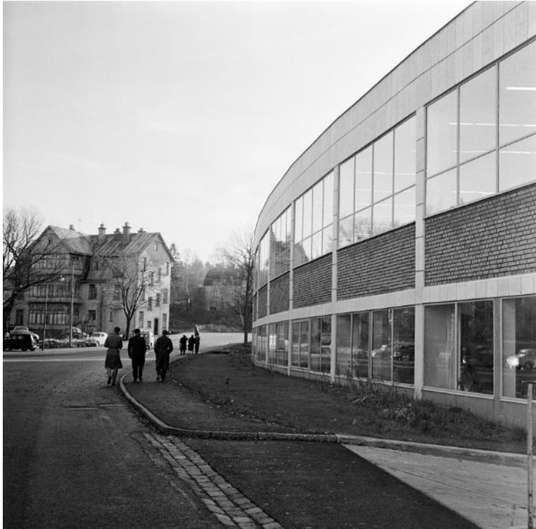
Foto 1958, strax efter färdigställandet av fabriken, som vill visa hur fasaden följer Planiavägens geometri. Fönstersektionerna och bröstningarnas tegelutfyllnader ge karaktär åt byggnaden. Det rationella modernistiska uttrycket samsas ännu med hantverksmässiga uttryck i tegelpartiernas mönstermurning. Foto Lennart af Petersens, Stockholms stadsmuseum.
