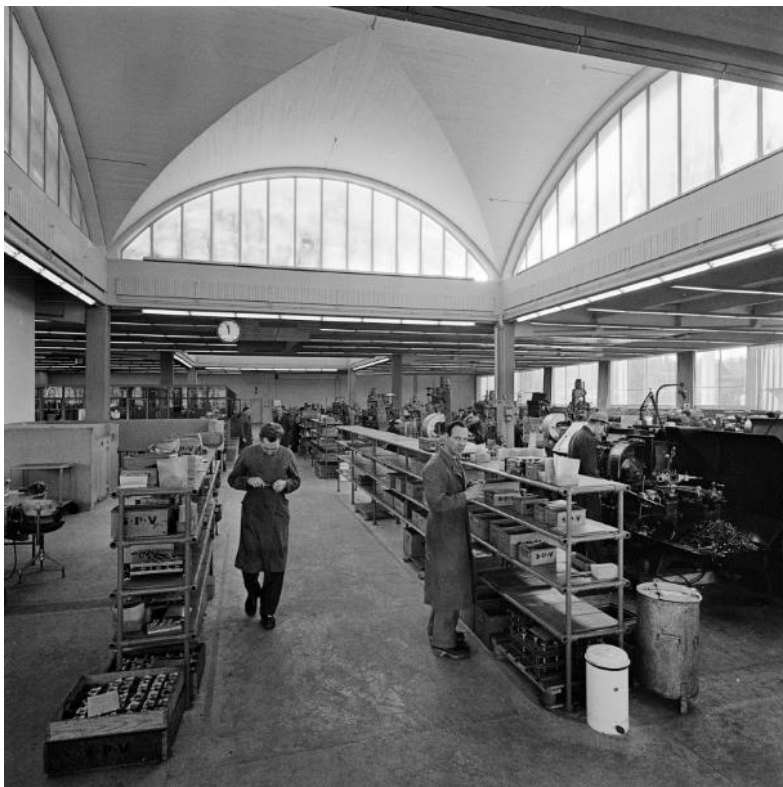
SPV:s verkstadshall badar i ljus från fönstren i kupolerna, vars valv nästan ger en kyrklig prägel åt lokalen. En modern pelar-balkkonstruktion av betong skapar en flexibel lokal med stor rymd och öppenhet. Foto Lennart af Petersens 1958, Stockholms stadsmuseum.
