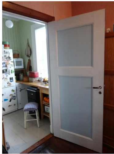
Ursprungliga dörrblad med två speglar. Den enkla dörrformen med två fyllningar anknyter på nationalromantiskt vis till ålderdomliga allmogedörrar som i sin tur hade hämtat dörrtypen från renässansens och barockens tvåfyllningsdörrar i högreståndsmiljöer. Trycke och nyckelskylt från byggnadstiden tidigt 1900-tal. Foto Johan Aspfors.
