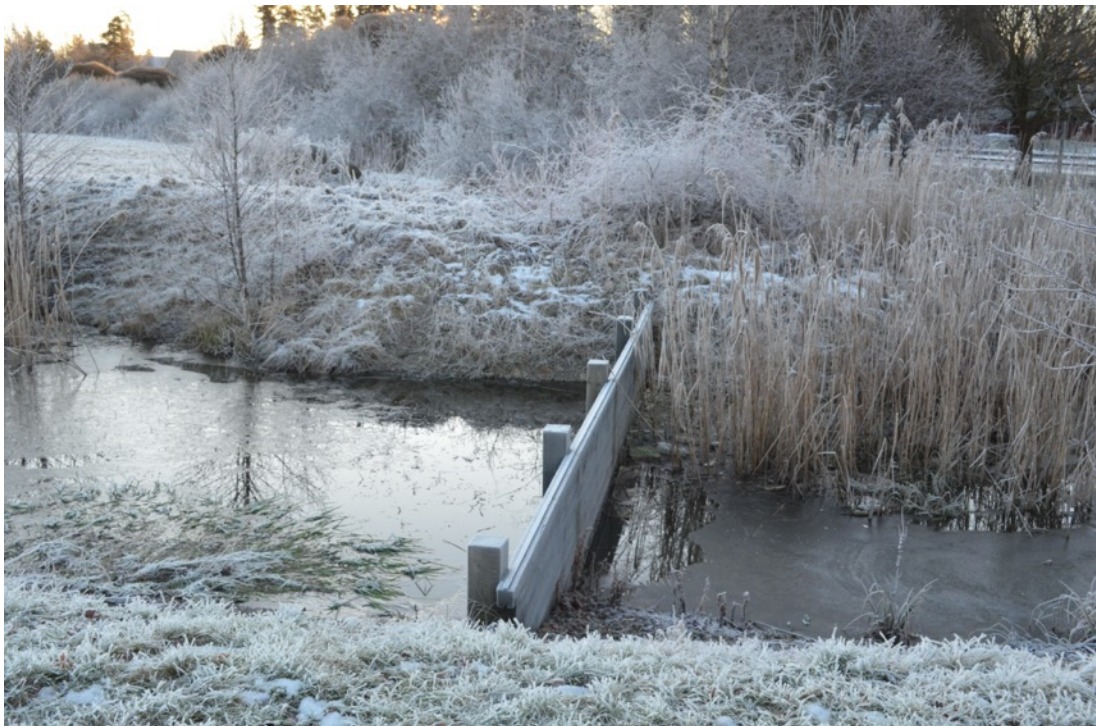
Figur 14. En träskärm avslutar fördammen och fungerar på så sätt som en olje- och skräpavskiljare. Vatten tillåts passera under skärmen och flytande orenligheter blir kvar i fördammen. Foto: Geoveta
