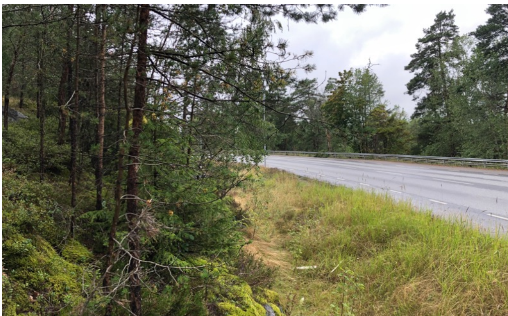
Figur 3. Väg diket längs Skarpövägen sett i riktning västerut. Foto: Geoveta
