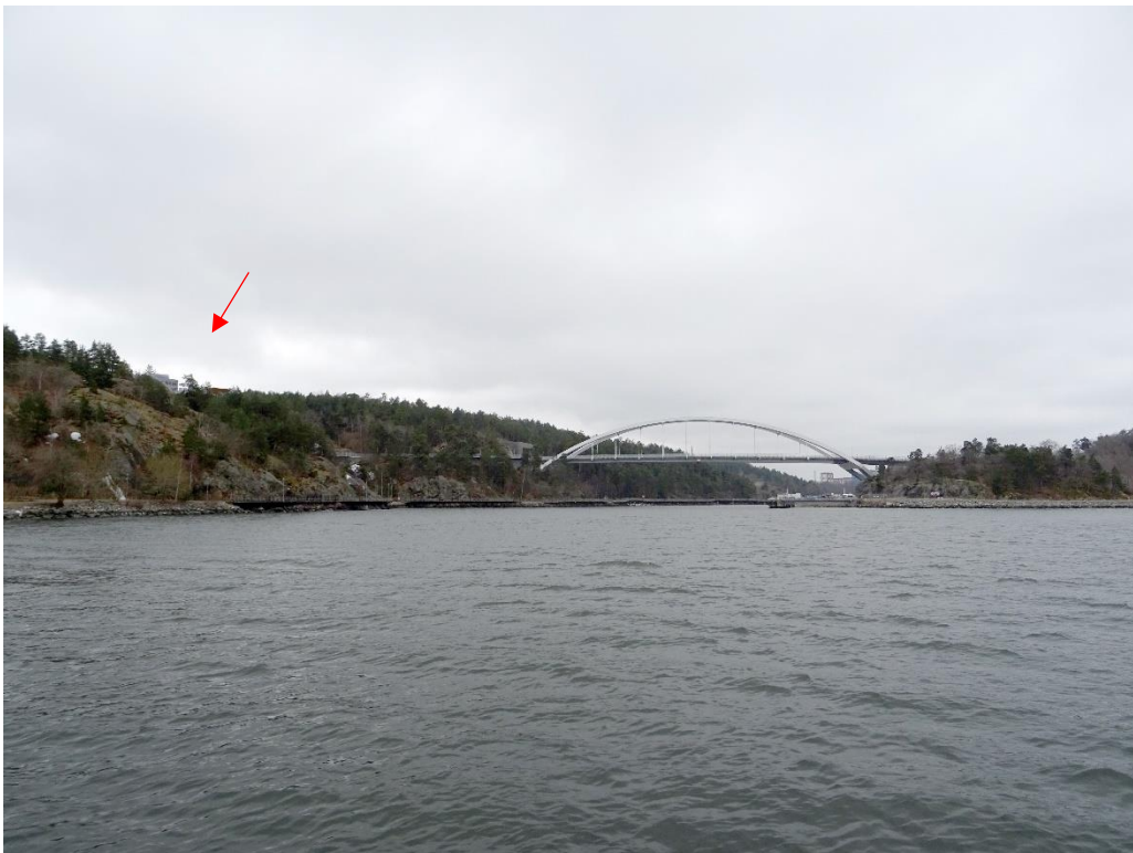
Figur 15. Gällande planförslag. Fotomontage, vy från farleden, fotopunkt 1. Pilen visar ungefärligt läge för synlig bebyggelse. Fotopunkten är belägen ca 4 m ovanför vattenytan.
