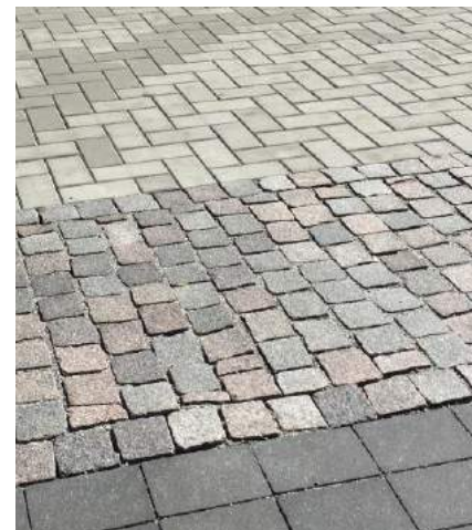
Smågatsten som delar av ytor.
