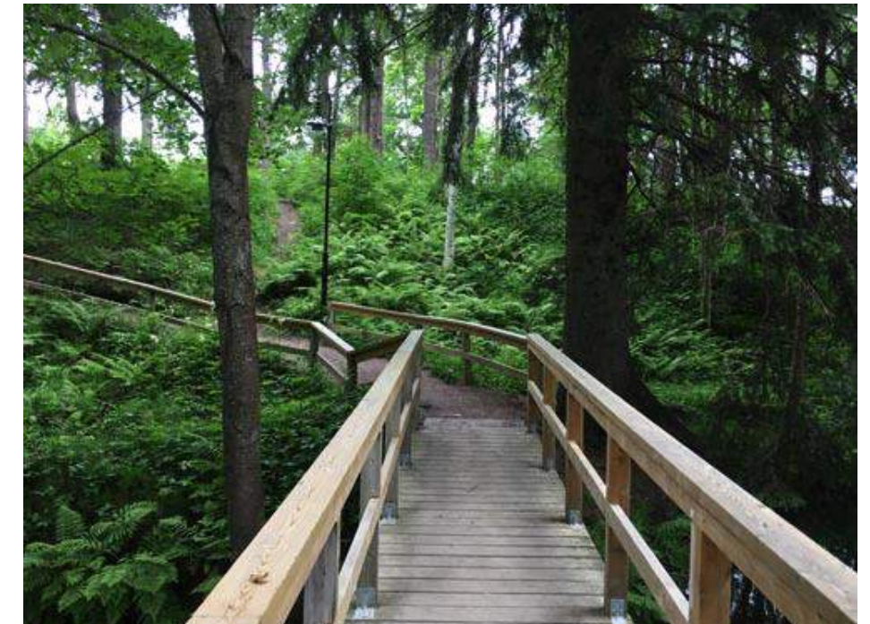
Träkonstruktion för att ta upp höjdskillnad
