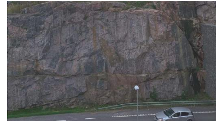
Referensbild. Bergskärning vid trafikplats Kvarnholmen.
