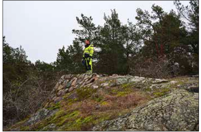
Fig 5. Ett murat skyttevärn inom objekt 2. Foto från väster.
