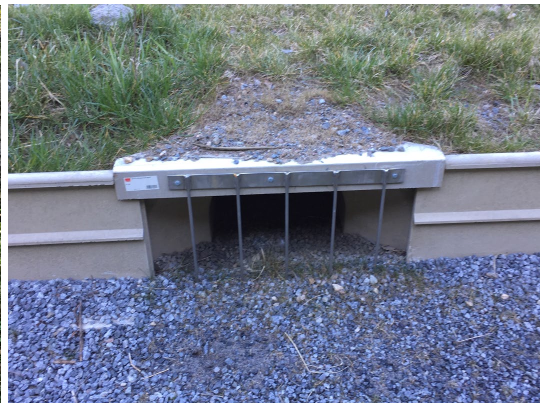
Nyanlagd grodtunnel (en av 6)
