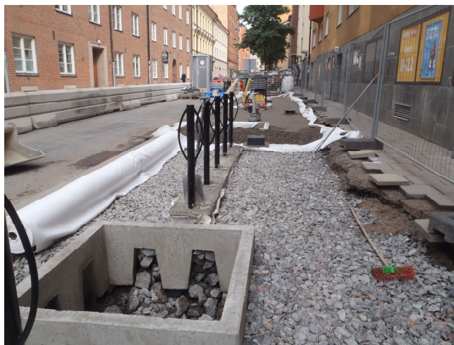
Figur 9. Exempel på etablering av skelettjord i befintlig miljö i Stockholm. Foto: Björn Embrén, Trafikkontoret Stockholm.
