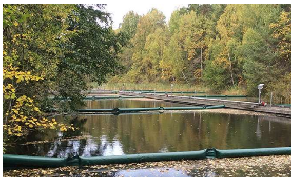
Reningsanläggningen vid Långsjön
