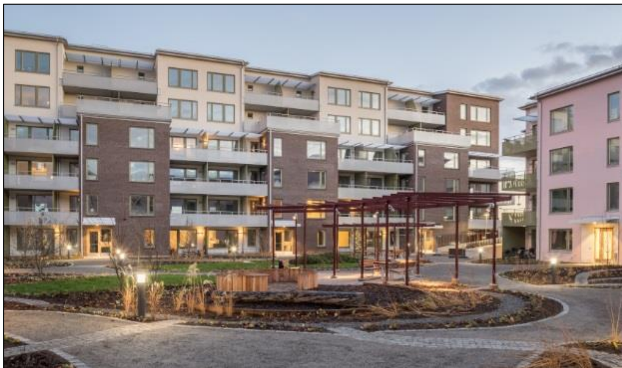
Figur 6-2 Avledning av takvatten till planteringar via rännor anlagda i gatsten. Exempelbild från Linnéhuset i Uppsala (Källa: Uppsalahem).
