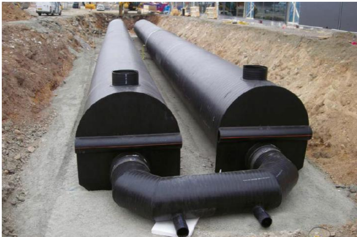
Figur 6-6 Underjordiskt rörmagasin
