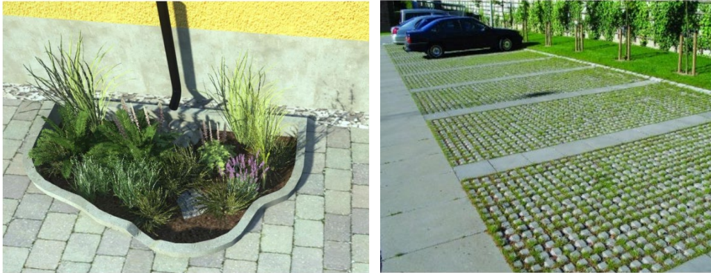
Förslag på genomsläppliga material och rening av dagvatten. Bilderna är hämtade från Anvisningar och principlösningar för dagvattenhantering på kvartersmark och allmän plats (Nacka kommun, 2018).
