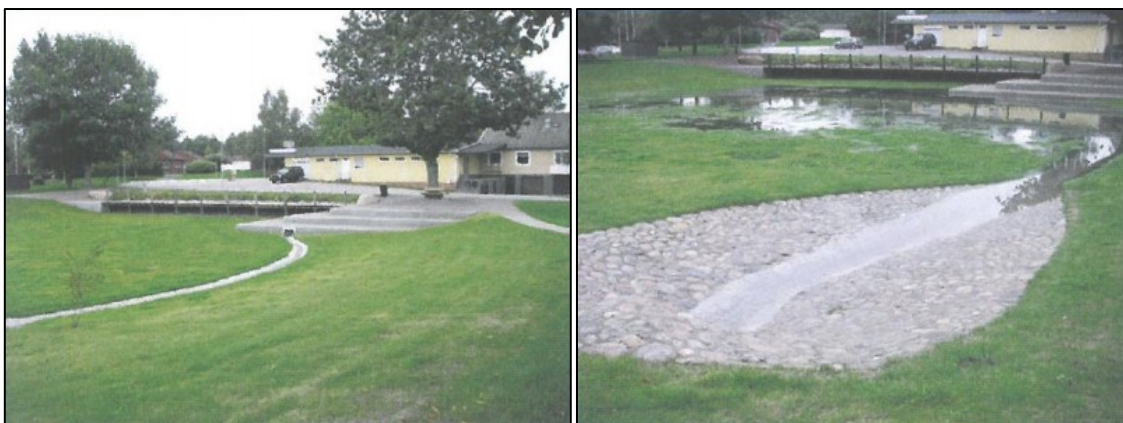
Figur 12. Öppet fördröjningsmagasin, tomt till vänster och med vattenspegel till höger (Publikation P105).
