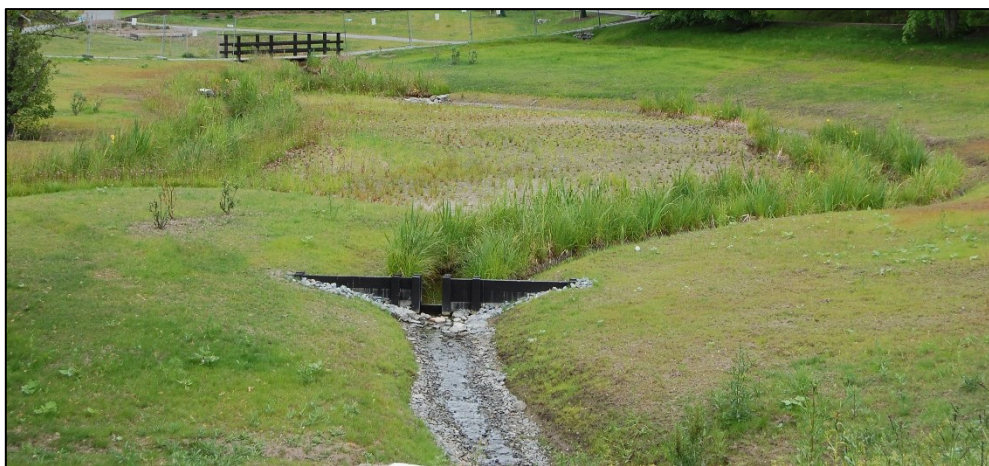
Figur 13. Dike med trappning/strykning av flöde (vegtech.se).
