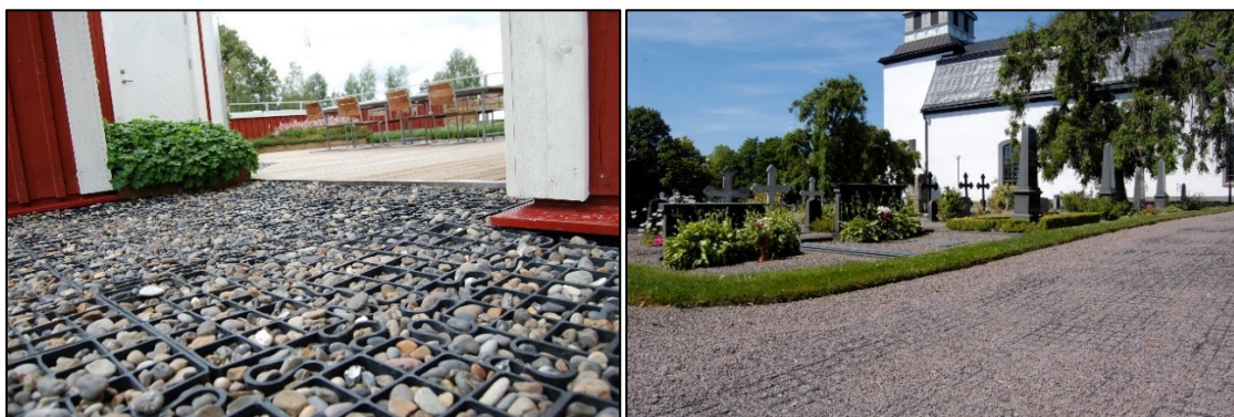
Figur 7. Markarmering, Pelleplatta fylld med sjösten (vänster bild) samt grus (höger bild). Bilder från www.vegtech.se .
