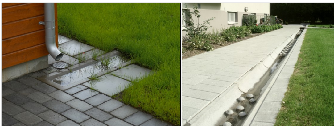
Figur 14. Öppna vattenutkastare och dagvattenrännor ( www.Steriks.se ).
