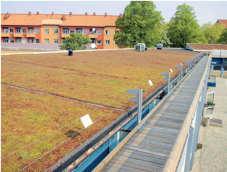
Bild 1. Grönt tak. En långsiktig hållbar dagvattenhantering, 2004.
