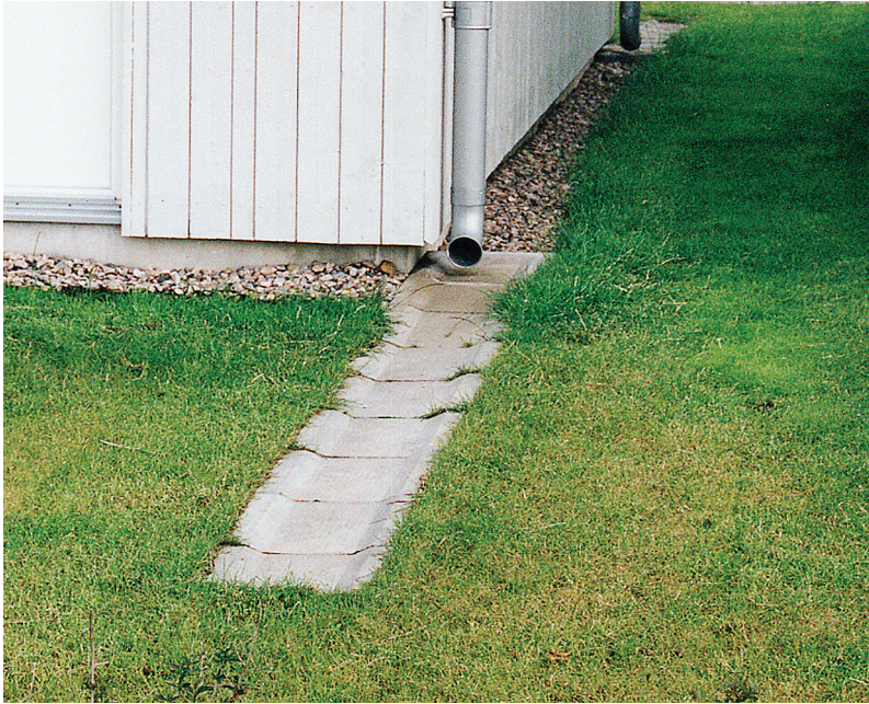
Bild 3. Detaljbild av stuprörsutkastare. En långsiktigt hållbar dagvattenhantering, 2004.
