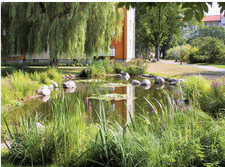
Bild 8. Lokal fördröjnings- damm i ett bostads- område. En långsiktigt hållbar dagvattenhantering, 2004.
