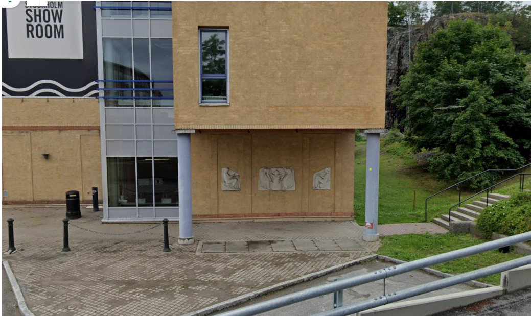
Figur 2. Mellan pelarna i den nordvästra änden av hus 9 finns befintliga rökluckor till garage
