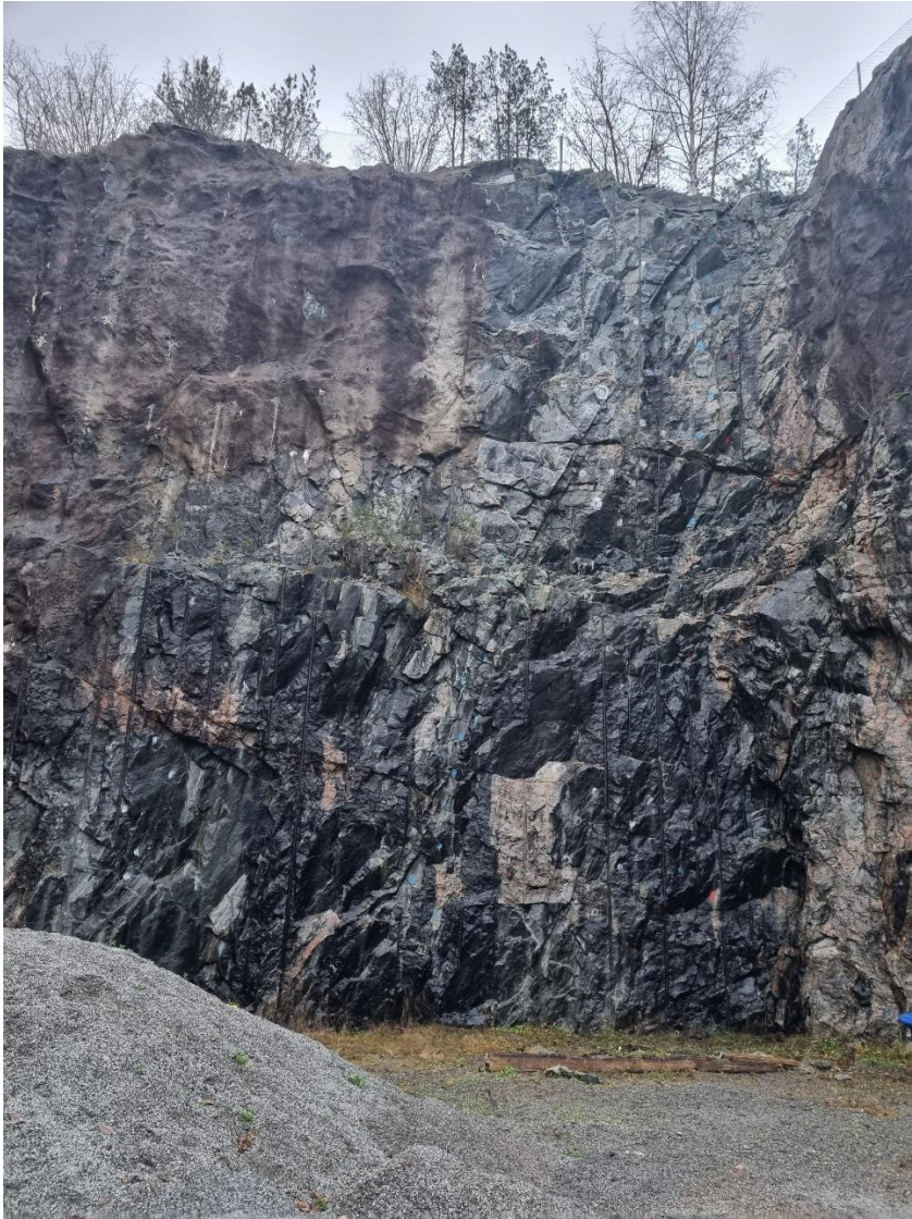
Figur 7. Glidplan i bergmassan orienterat 90° från det kritiska glidplanet. Foto taget 2025-12-09.
