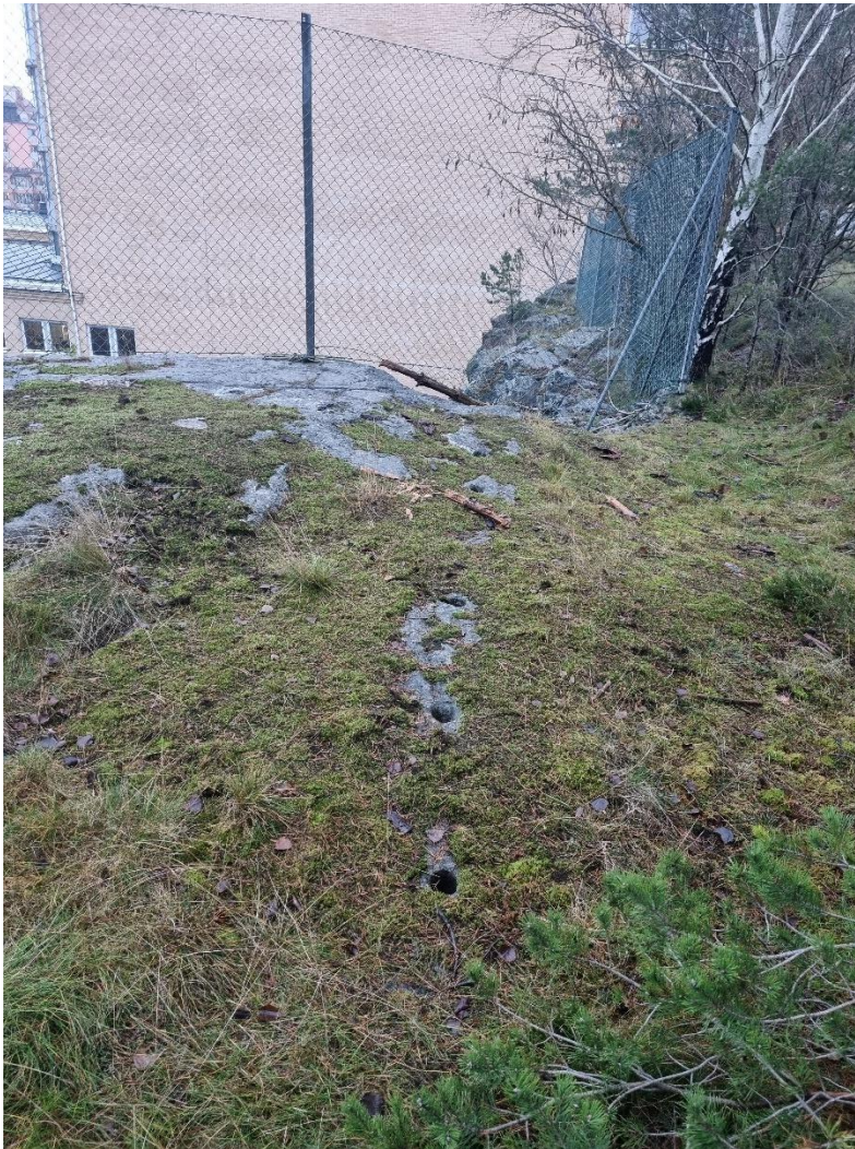
Figur 10. Konturhål för planerad bergschakt som inte lossållits, hålavstånd ca 0,5-0,6 m
