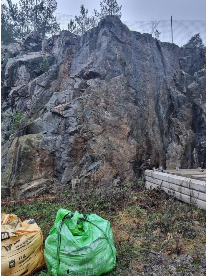
Figur 9. Bergbult för säkring av den lösa bergskivan.
