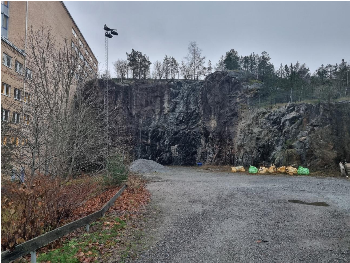
Figur 2. Bergskärning ca 20 m hög i fastighetens sydöstra del. Framför skärningen ligger nordöstra platån på ca+35. Foto taget 2025-12-09.
