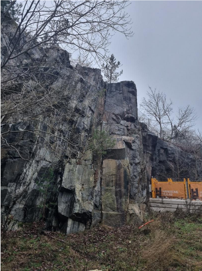
Figur 8. Lös bergskiva säkrad med bergbult. Foto taget 2025-12-09.
