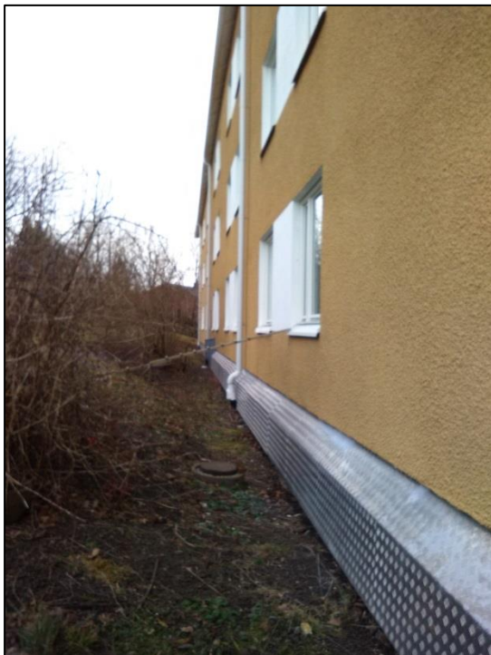
Figur 11. Området norr om befintlig fastighet som enligt Nacka kommuns skyfallsanalys kan drabbas av stående vatten vid ett 100-årsregn.
