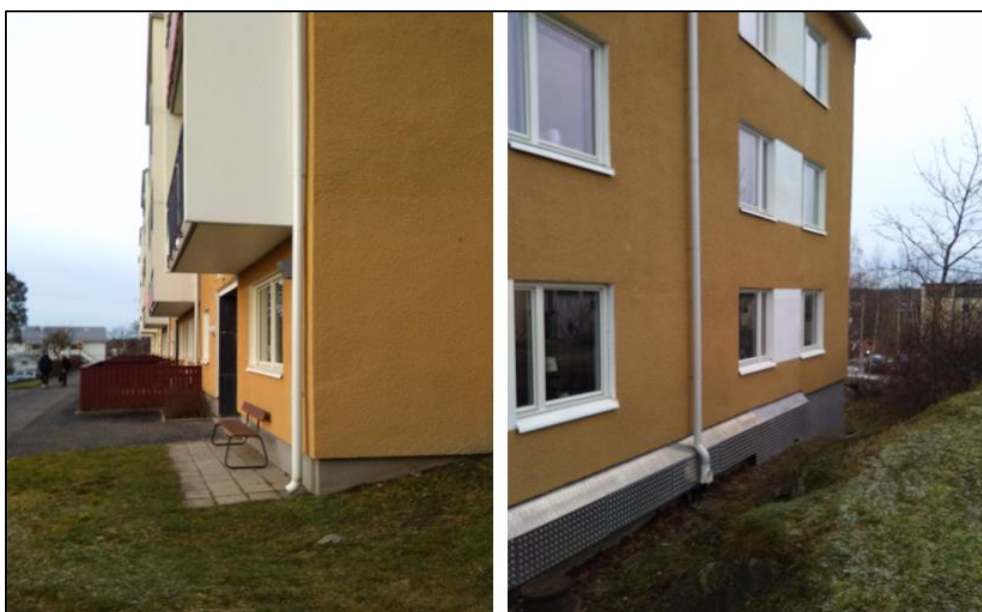
Figur 2. Stuprör med utkastare samt stuprör som leder ner till marken
