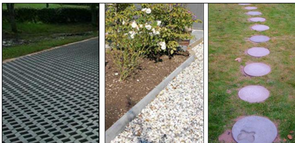
Figur 7. Yta med hålsten av betong, makadambelagd gång, samt gångstig med gräs och ett fåtal gångplattor
