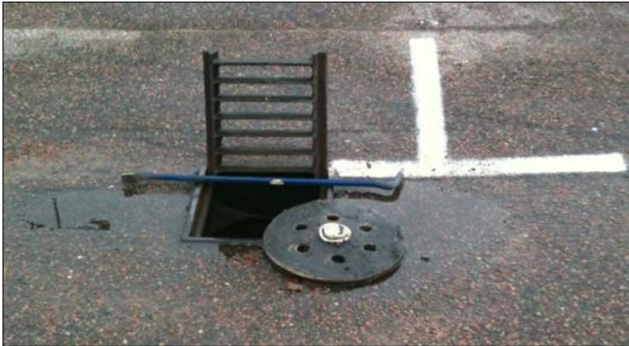
Figur 8. Filterplatta som placeras i rännstensbrunn (Acitex, 2016)
