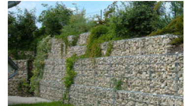
Referens murar i gabion murar.
