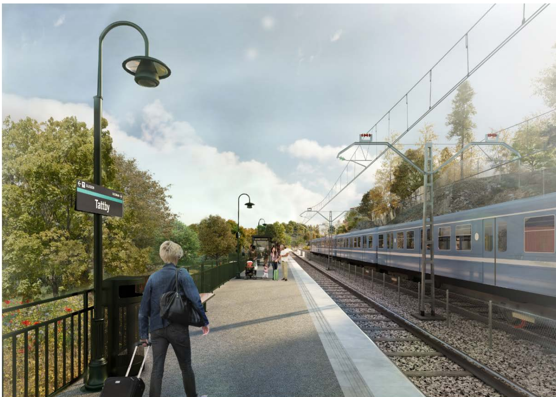
Spårområdet breddas för att rymma dubbelspår, vy från väster. Visualisering av Sweco.
