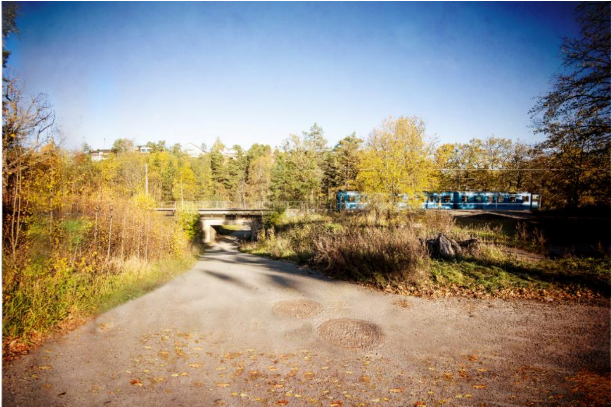
Dagens gång- och cykelväg och gång- och cykeltunnel, vy från söder. Foto av Sweco.
