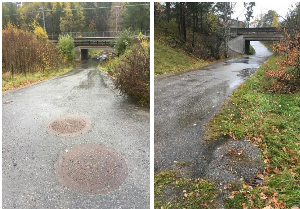
Figur 13. T.v. vy mot viadukt från söder mot norr. T.h. vy mot viadukt från norr mot söder med befintlig dagvattenbrunn i förgrund.
