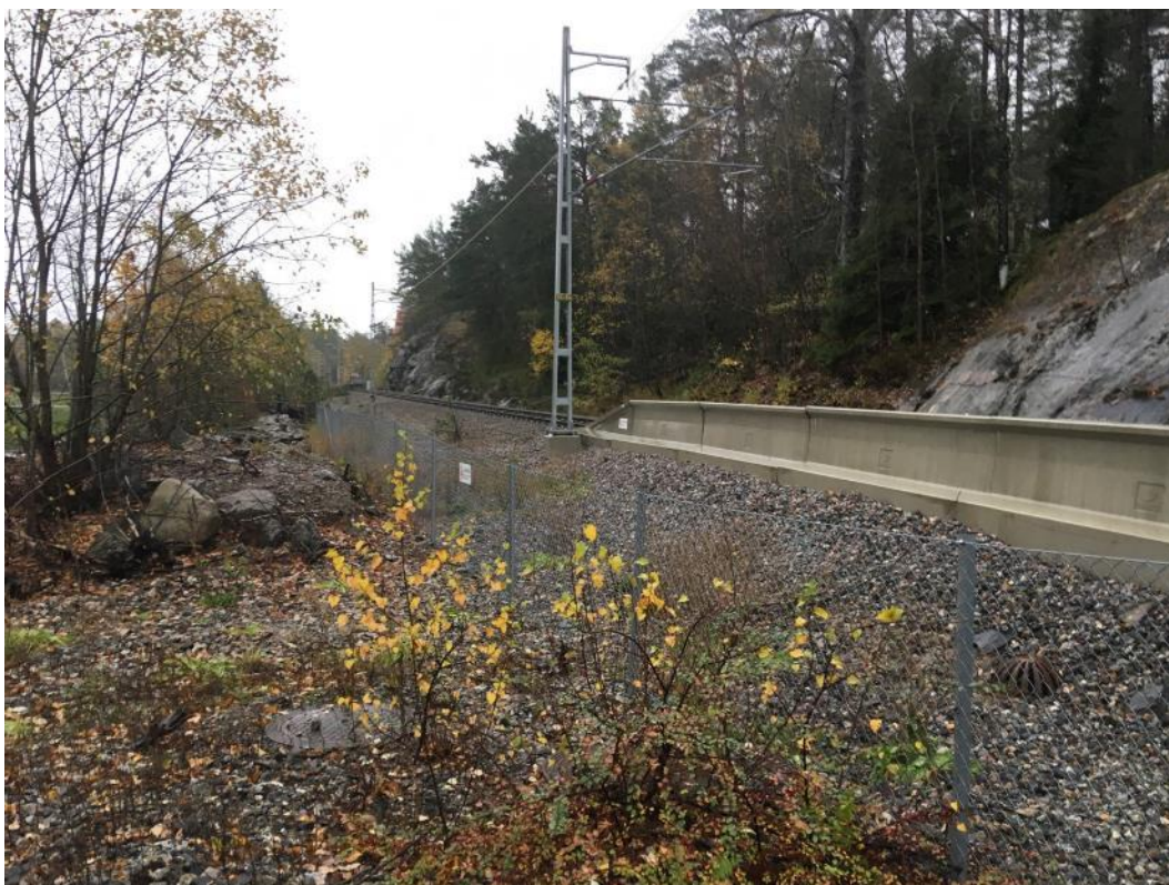
Figur 15. Vy från norr, där norra delen av de nya plattformarna ska placeras. Befintlig kupolsilsbrunn och spolbrunn.
