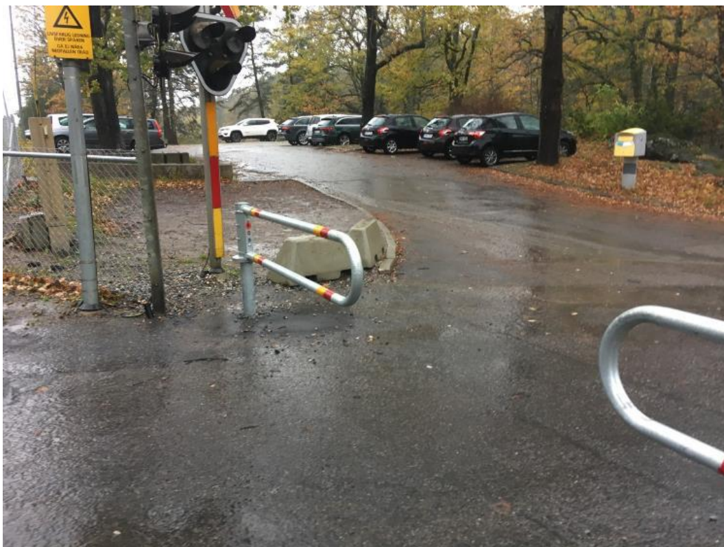
Figur 9. Infarten till parkeringen är hårdgjord varifrån dagvatten avrinner mot byvägen.
