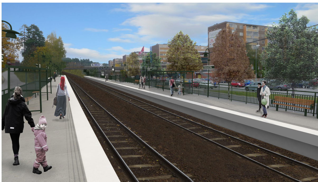
Exempel på asfalts/betongplattform med typutrustning i Fisksätra.
