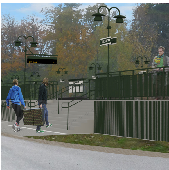
Klotterskyddande ribb på plattformsbakkant
