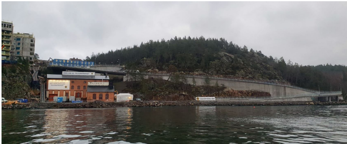
Vy från vattnet mot söder. Visar befintliga tegelbyggnader samt anöringsvägen.
