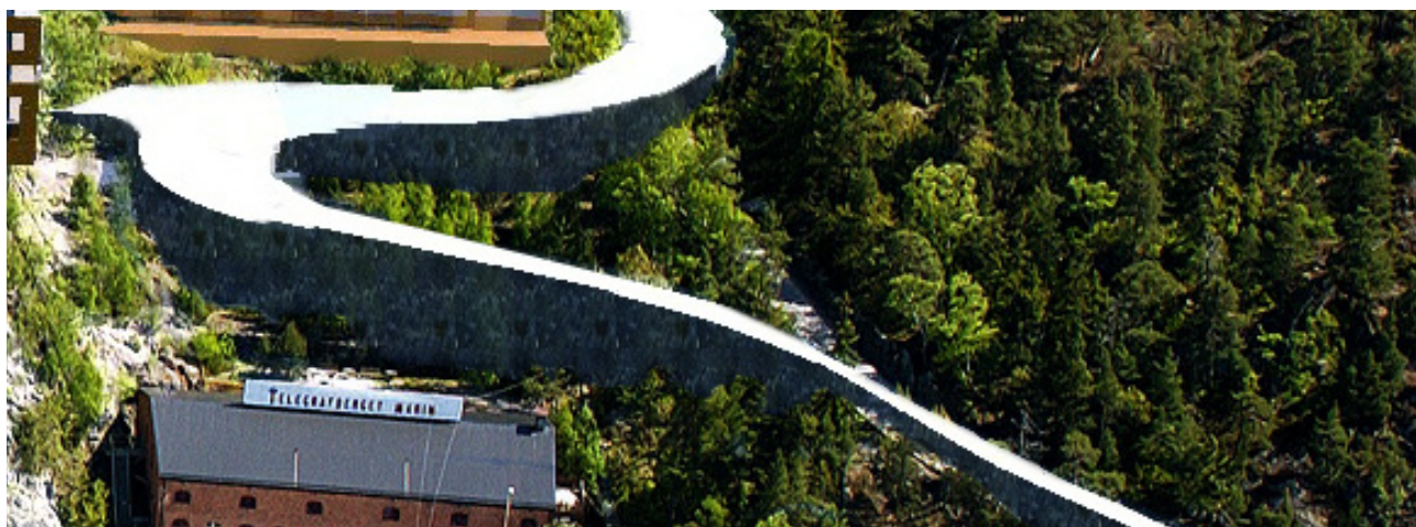
Stödmur klädd med vegetation
