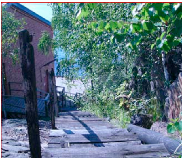
Trätrappa mellan kaj och övre oljecisterner
