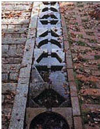
Exempel på omsorgsfull dagvattenhantering där material, strandskoning och växtlighet valts för att bli ett positivt tillskott i den kringliggande miljön. Vid stor nederbörd och höga flöden vattenfylls större diken och fungerar som fördröjningsmagasin.
