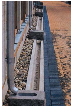
Exempel på omsorgsfull dagvattenhantering där material, strandskoning och växtlighet valts för att bli ett positivt tillskott i den kringliggande miljön. Vid stor nederbörd och höga flöden vattenfylls större diken och fungerar som fördröjningsmagasin.
