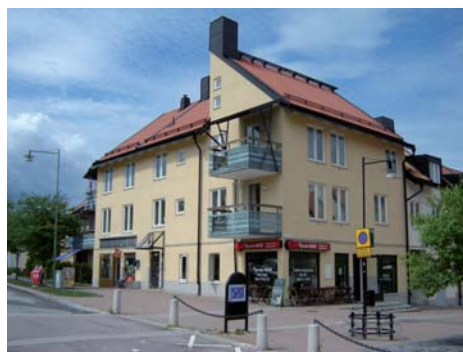
Service i bostadshusens bottenvåning ger liv åt stadsrummet, Tyreso Strandtorget. (Arken Arkitekter)
