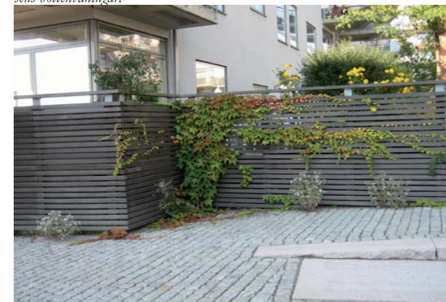
Exempel på spaljélösningar som omger uteplatser i flerbostadshusens bottenvåningar.
