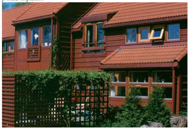
Exempel på spaljélösningar som avskiljare mellan radhusens privata uteplatser.
