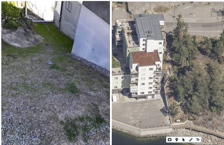
Figur 30: (Vänster) Mark för rinnstråk öster om byggnaden på Tollare 1:455. Sedd från Tollareslingan och mot söder. Foto: Nacka kommun. (Höger) Den östliga byggnaden med närområde på Tollare 1:455, sett från söder. Källa: Mapspace 2025.
