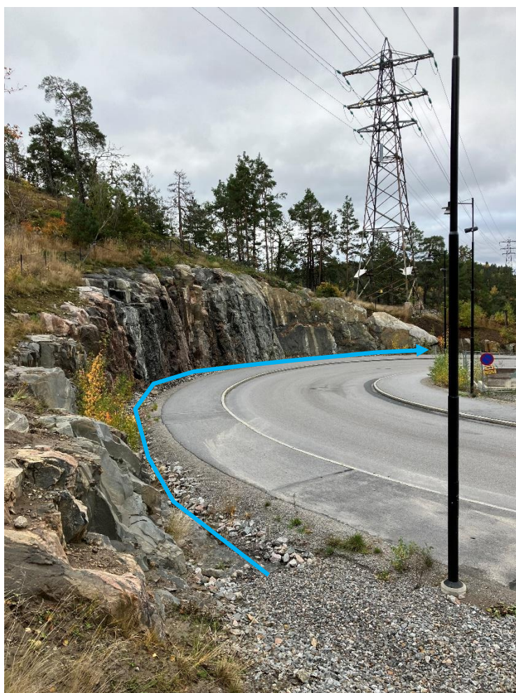
Figur 6. Krossdike längs med Tollareslingan som tar emot vatten från bergsslänten. Vatten från Tollareslingan når inte krossdiket eftersom vägen är skevad åt motsatt riktning (inåt kurvan).
