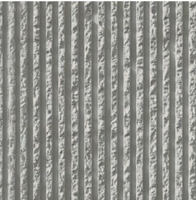
Fasader mellan hus4:1/4:2/4:3: Profilerad betong som underlag för klättrande grönska
