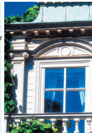
Detalj från manbyggnaden Tollare Gård.
