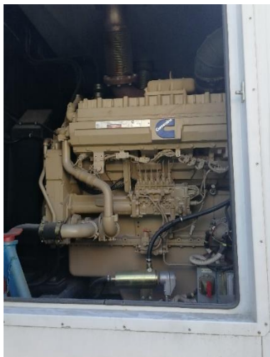
Figur 1: Motorn i det större reservkraftaggregatet.
