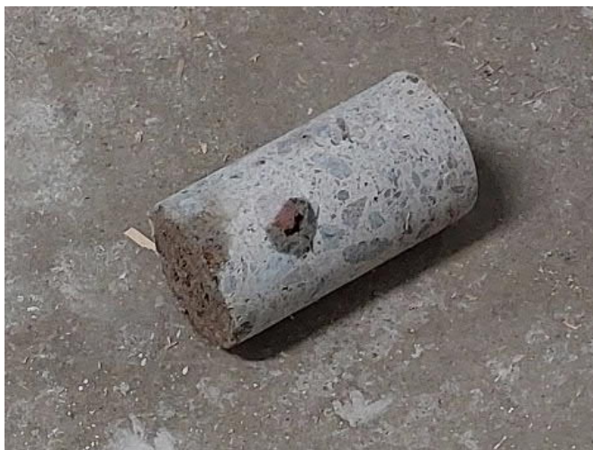
Figur 6. Betongkärna uttagen i punkt 22W315_PL9.
