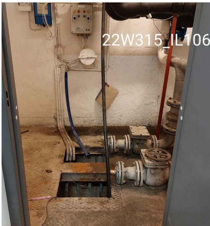
Figur 7. Pumprum med hål ned till pumpgrop på källarplan i Hus 315. Utöver vatten provtogs luft i pumpgropen ovan vattenytan (22W315_IL106, vars beteckning syns i bilden).
