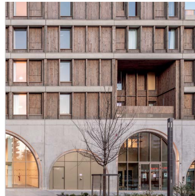
Bostadshus med bottenvåning, pelare och bjälklag i betong med utfackningsfasader i trä, CoBe arkitekter och landskap Paris
