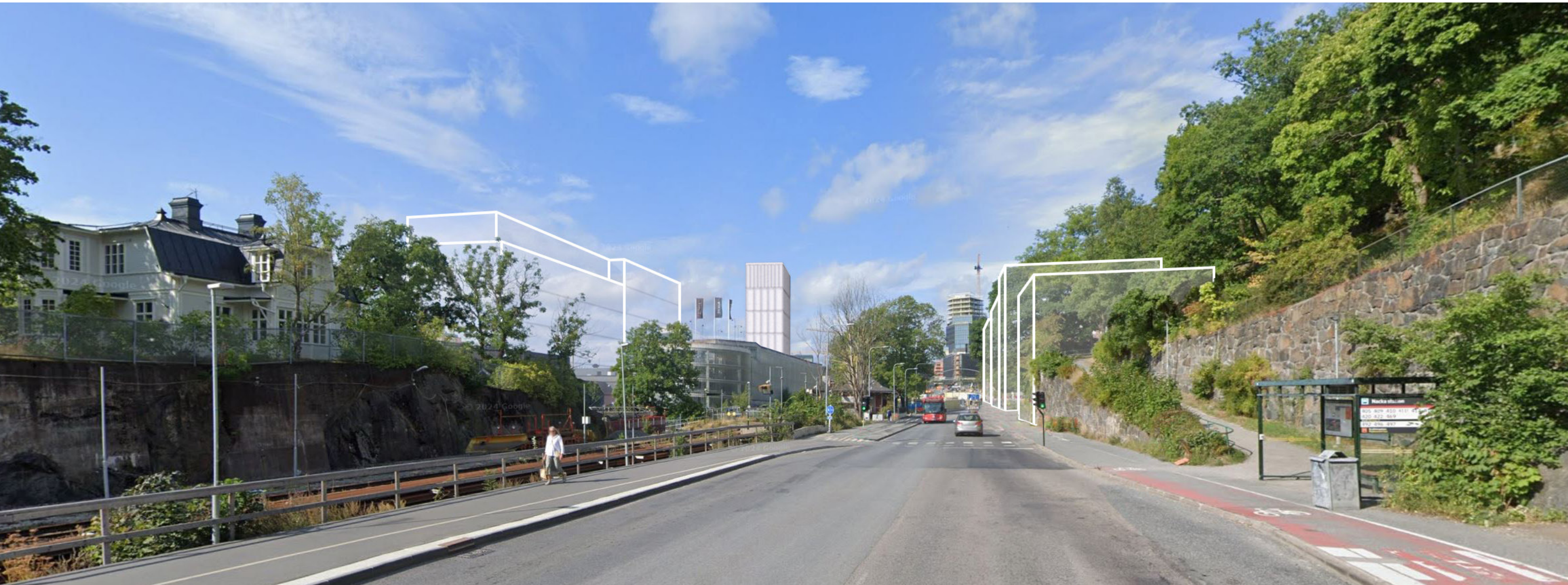
Från Värmdövägen från väster
