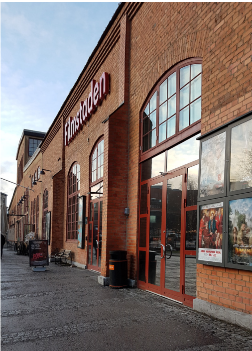
Delar av fasaden på Diselverksaden är helt i tegel med kraftfulla strukturella strävor.
