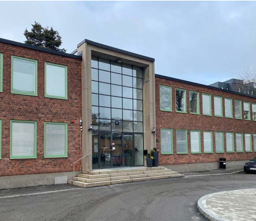
Företagarecentrum (tidigare Affärskontoret) från 1939 har fasader i rött tegel med fin variation mellan stenarna. Ett omsorgsfullt gestaltat entreparti bestående av en kraftig kalkstensklädd ram som omsluter ett generöst glasparti bryter av den horisontella byggnadskroppen i 2 vån.
