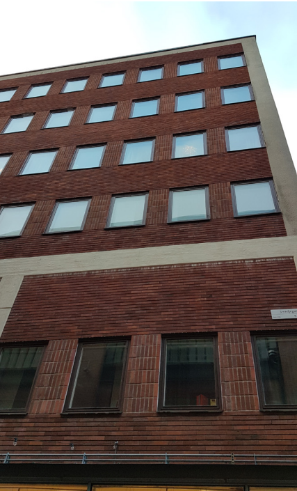
Kontorsdel från 60 talet som dockar på Diselverkstaden i öster med en stram rationell fasad i en brunrött djupare tegelkulör med viss variation. Bärande och buret beskrivs dels med olika tegelriktningar dels med målade delar och hörnelement i puts.
