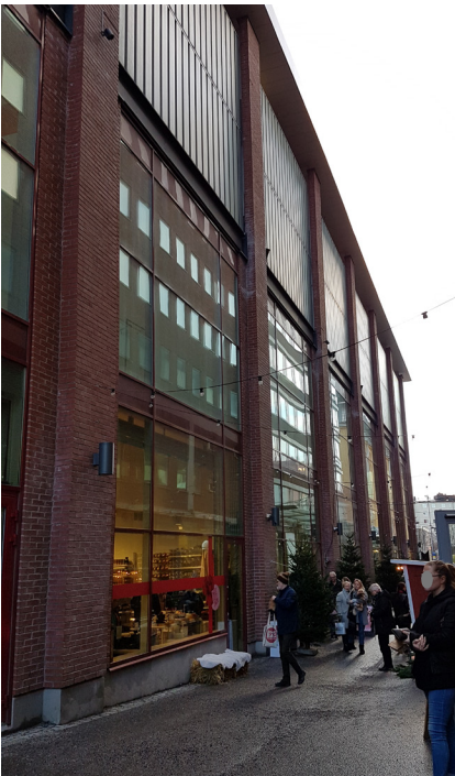
Tydliga tegelpilastrar förstärker det bärande i en av gallerians nyare delar
