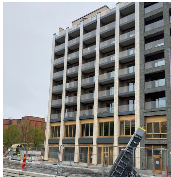
Fasad i tegel och trä på trästomme med tydlig vertikalitet Stadshagen Archus
