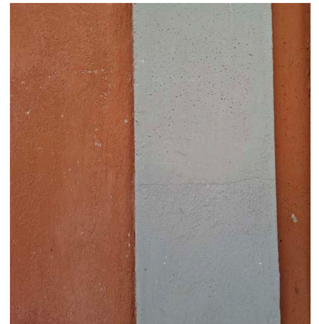
Putskulörer bef byggnad inom Kv Tryckluftsfabriken
