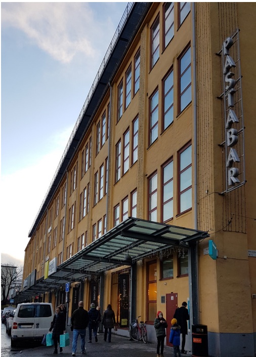
Luftverkstadens putsfasad uppvisar en strukturell tydlighet genom sitt spel mellan horisontellt och vertikalt. De något utstickande pilastrarna ger en fin skugg och djupverkan och de i sig vertikala fönstren ger en horisontellt intryck genom att grupperas 3 och 3 i ett band längs hela fasaden.
