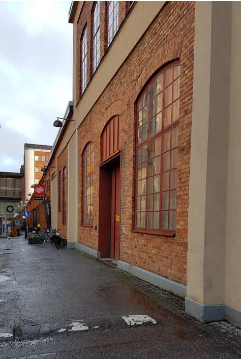
Diselverkstadens fasad med tydlig struktur där putsade delar beskriver bärande och buret och inramar fasad delar i ljust gulrött varierat tegel med större välvda dörr och fönster öppningar.
