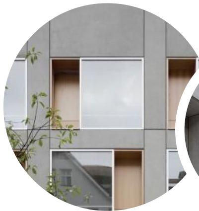
Prefabricerade betongelement där elementen underbygger fasadkompositionen.
