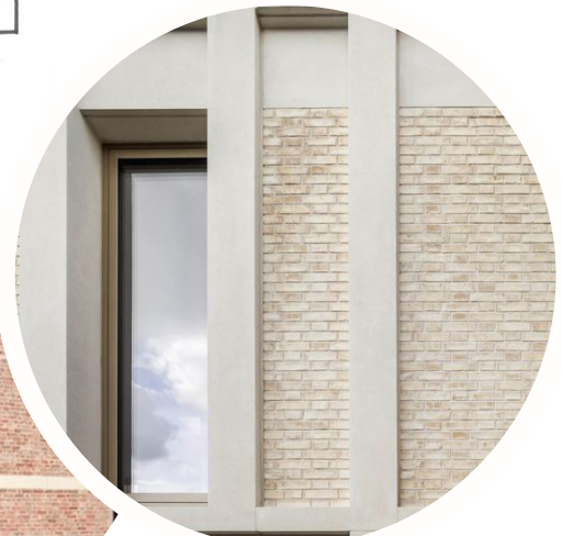
Exempel på djupverkan i fasadliv här med inslag av betong.
