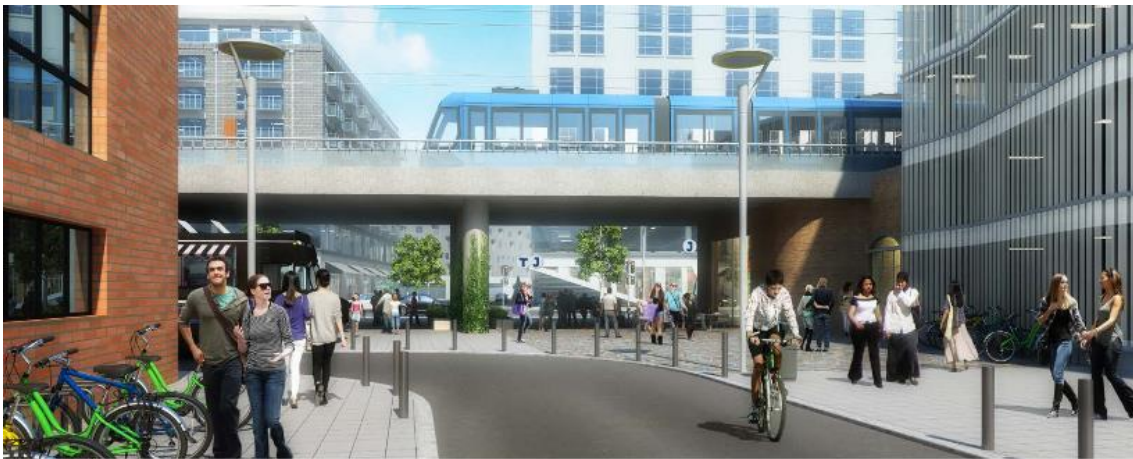
Figur 10: Upphöjning av Saltsjöbanan i höjd med lokalgatan vid Traversen (White och Atkins 2015)
