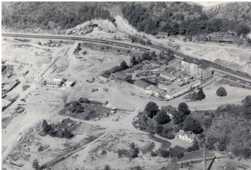
Fanny Udde på 1960-talet. 1800-talsvillans tak syns bland träden söder om färgfabrikens inhägnade område, rester av udden till vänster. Långnets trafikplats och Värmdöleden var ännu inte byggda
