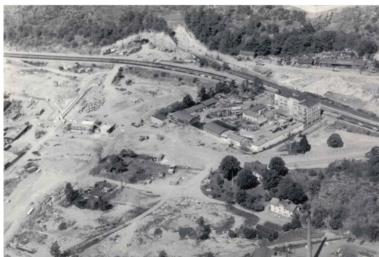
Fanny udde på 1960-talet. 1800-talsvillans tak syns bland träden söder om färgfabrikens inhägnade område, rester av udden till vänster. Lugnets trafikplats och Värmdöleden var ännu inte byggda.
