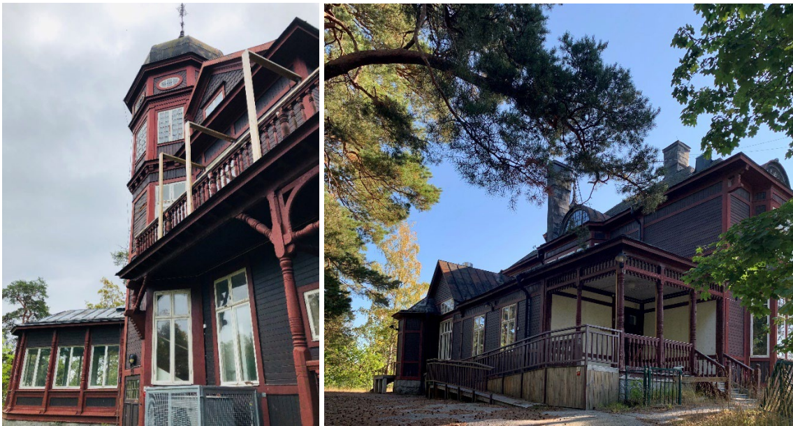
Figur 3 & 4. Villa Gadelius norra fasad (t.v.) samt västra fasad (t.h). Foto: Nacka kommun, 2020
