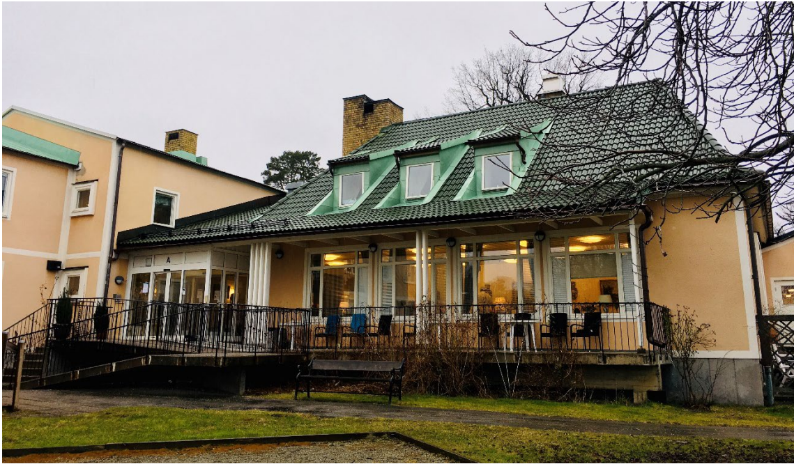
Figur 6. Seniorcenter Sjötäppans huvudentré. Byggnaden är den mittersta av de tre huskroppar som föreslås regleras med skyddsbestämmelser. Foto: Nacka kommun 2020
