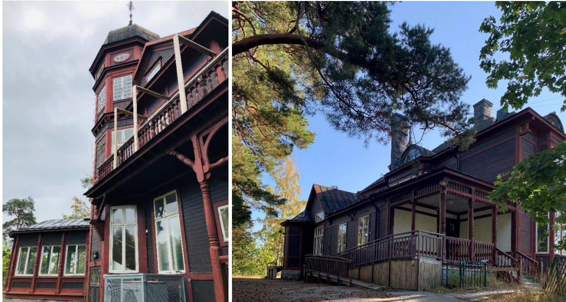
Figur 3 & 4. Villa Gadelius norra fasad (t.v.) samt västra fasad (t.h). Foto: Nacka kommun, 2020
