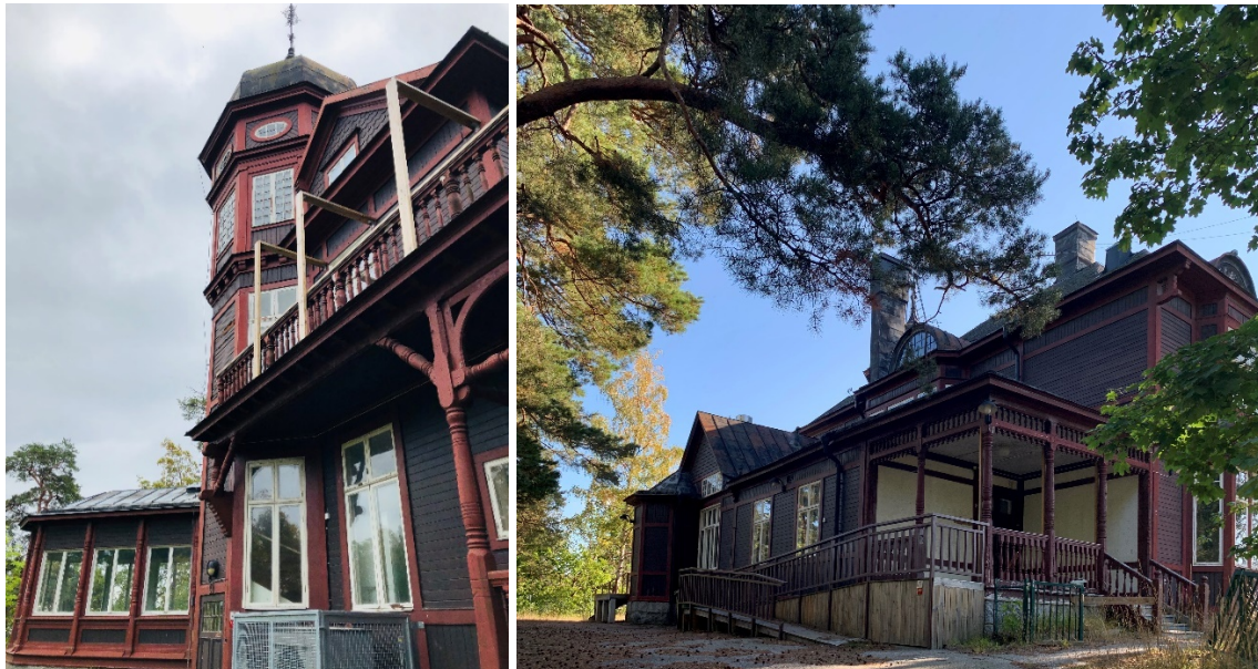
Figur 3 & 4. Villa Gadelius norra fasad (t.v.) samt västra fasad (t.h). Foto: Viktor Wallström
