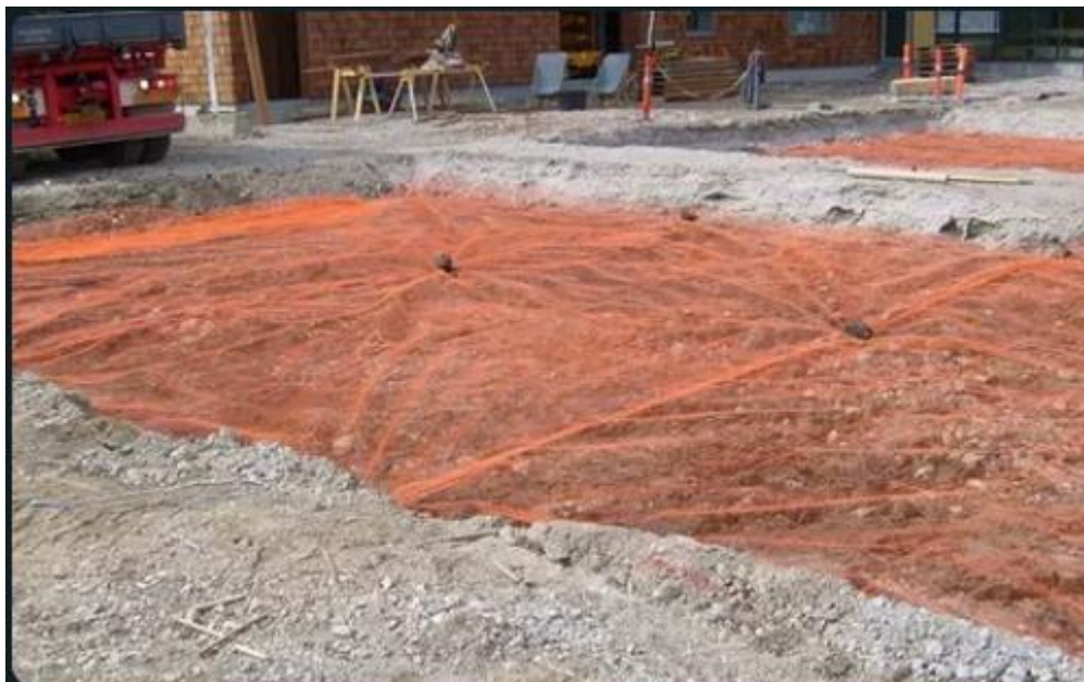
Figur 1: Exempel på hur det kan se ut efter saneringsåtgärd där markeringsnät lagts ut efter schakt (Foto från: https://northex.se/markprodukter/geonat-och-forstarkningslager/signal-och-markeringsnat/ )
