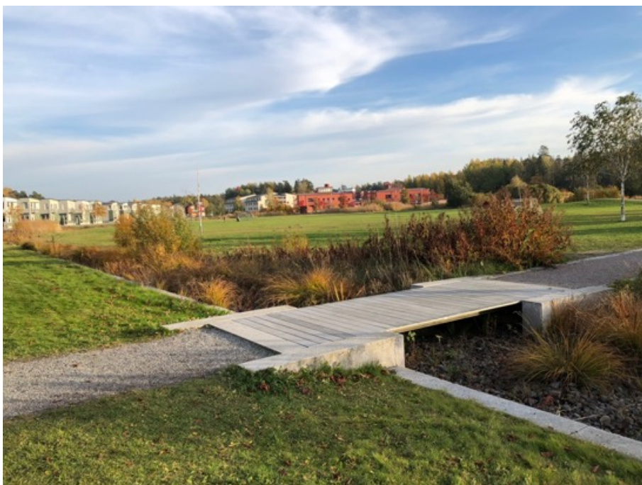
Figur 11. Exempel på en torrdamm i kombination med krossdike. I detta fall har dammens kanter uppförts med stenblock, givetvis kan kanterna även utformas som mjuka slänter. Figuren visar även på hur en passage för gång- och cykeltrafikanter kan utformas utan att påverka dagvattenflödet. Foto: Geoveta.
