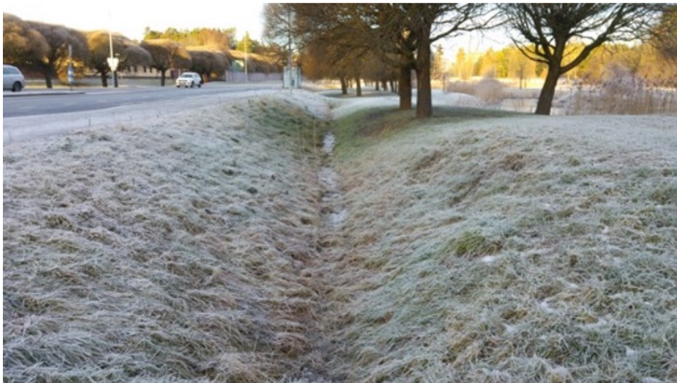
Figur 9. Exempel på svackdike. Foto: Geoveta
