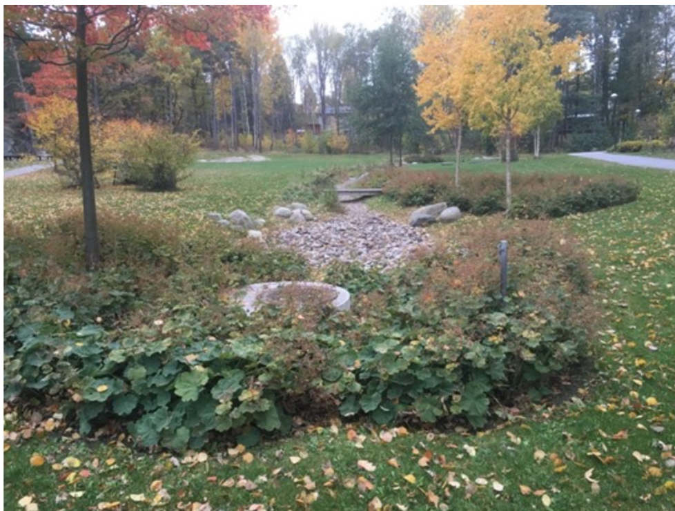
Figur 10. Svackdike med stenkross utan vattenspiegel. Foto: Geoveta.
