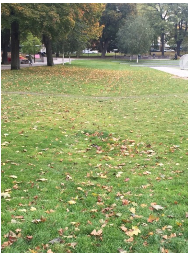
Figur 12. Exempel på mer diskret torrdamm. En svacka i gräsytan som avvattnas med en kupalbrunn i lågpunkten. Foto: Geoveta
