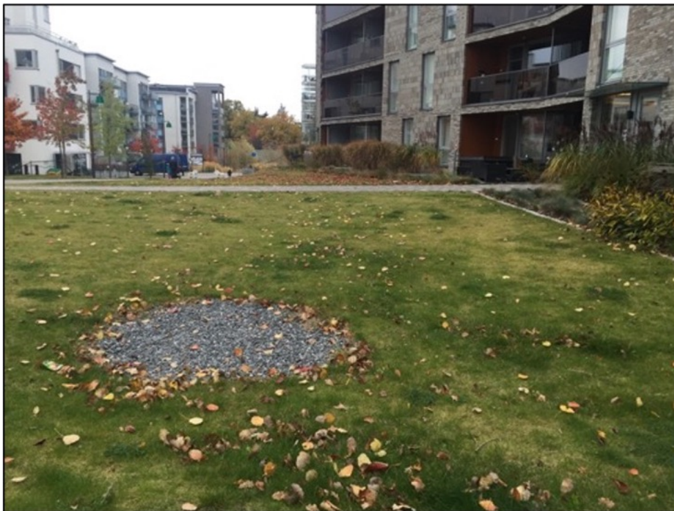
Figur 8. Infiltrationsyta där en central punkt har krossmaterial för snabbare infiltration till dräneringssystem. Foto: Geoveta
