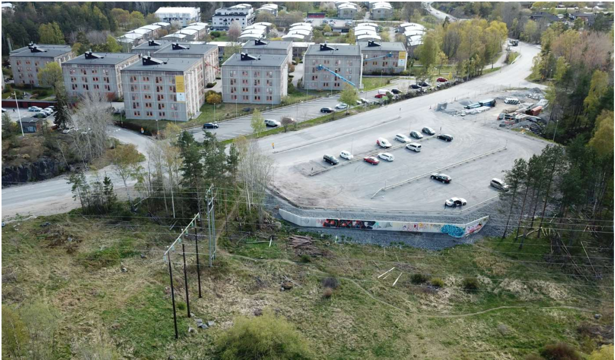
Figur 2 Flygfoto taget mot sydväst som visar befintliga konstruktioner. Inom planområdet förekommer en grusyta för parkering med upplagsyta i väst (bortom parkeringsytan i bild) och stödmur i nordöst (hitom parkeringsytan i bild). Luftledningarna förekommer inom planområdet.
