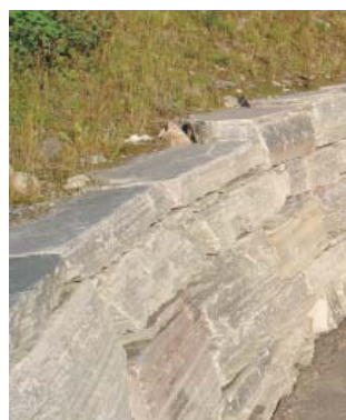
Referens stödmur i staplade skifferblock, Norge
