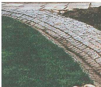
Stensatt rännadal i kant av plattytta.
